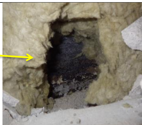
Kuva 2. Ulkoseinän rakennetutkimuskohta huoneessa 131 (2).
