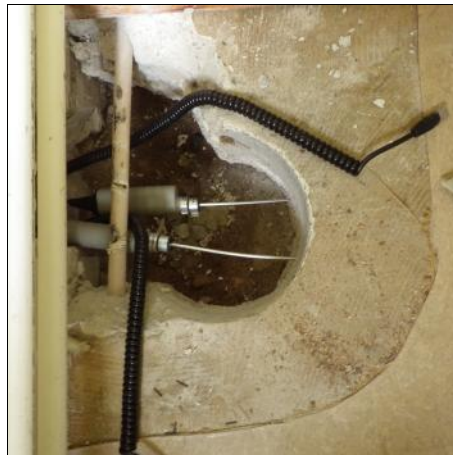
Kuva 9. Alapohjarakenteen kosteusmittausta RT3-kohdasta.
