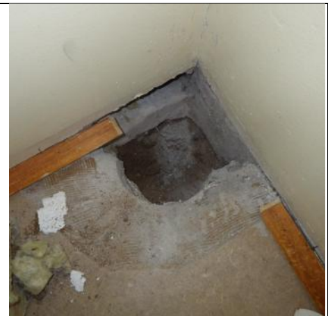
Kuva 10. Alapohjan rakennetutkimuskohdasta (RT4) huoneessa 144 (4).
