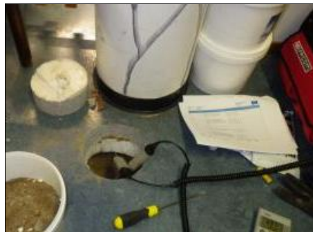
Kuva 5. Alapohjan rakennetutkimuskohda käytävällä 161.
