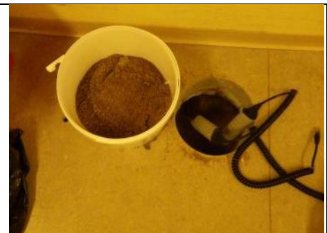
Kuva 6. Alapohjan rakennetutkimuskohda RT2, käytävällä 178.
