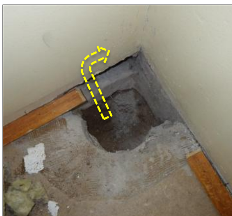
Kuva 3. Ulkoseinän rakennetutkimuskohta huoneessa 144 (4). Kuva 4. on otettu rakenneavauksen sisältä oikealle.
