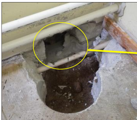
Kuva 1. Ulkoseinän ja alapohjan rakennetutkimuskohta huoneessa 131 (2).
